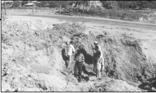
পতেঙ্গা কামানটিলা বধ্যভূমিতে চলছে খনন কাজ
